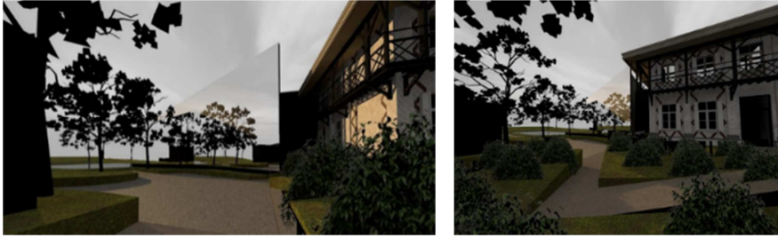
Nieuwbouw met reflecterende gevelbekleding
